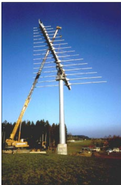
Kommersiell mycket stor LPD-antenn för 5-30 MHz. Högeffektsutförande 100 kW.
